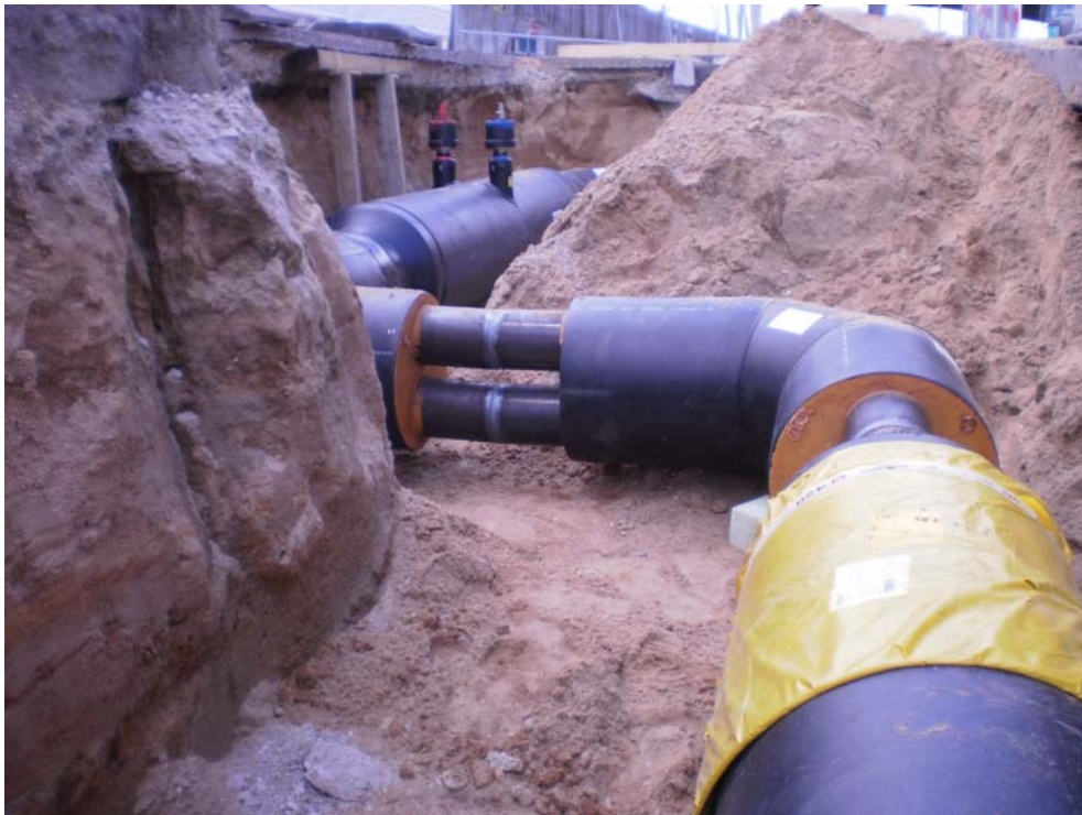
Doppelrohr der Dimension 2x DN 150; Außendurchmesser 450 mm
