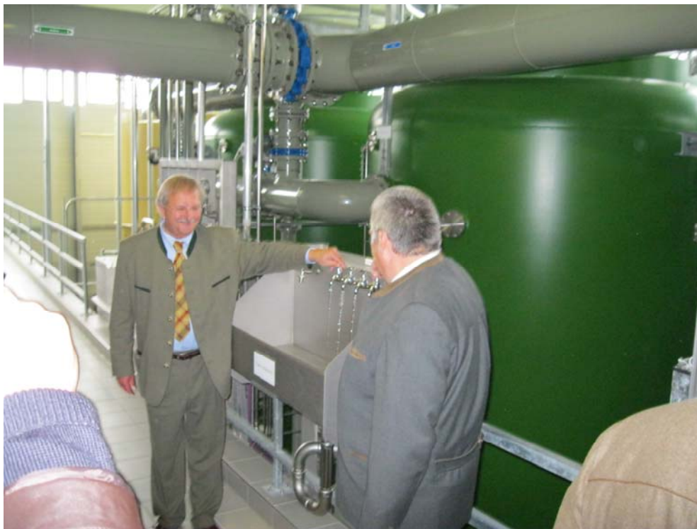
Offizielle Inbetriebnahme der Kreither Brunnen
