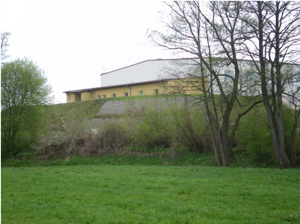
Ansicht der Aufbereitungsanlage von der Straße nach Irlaching
