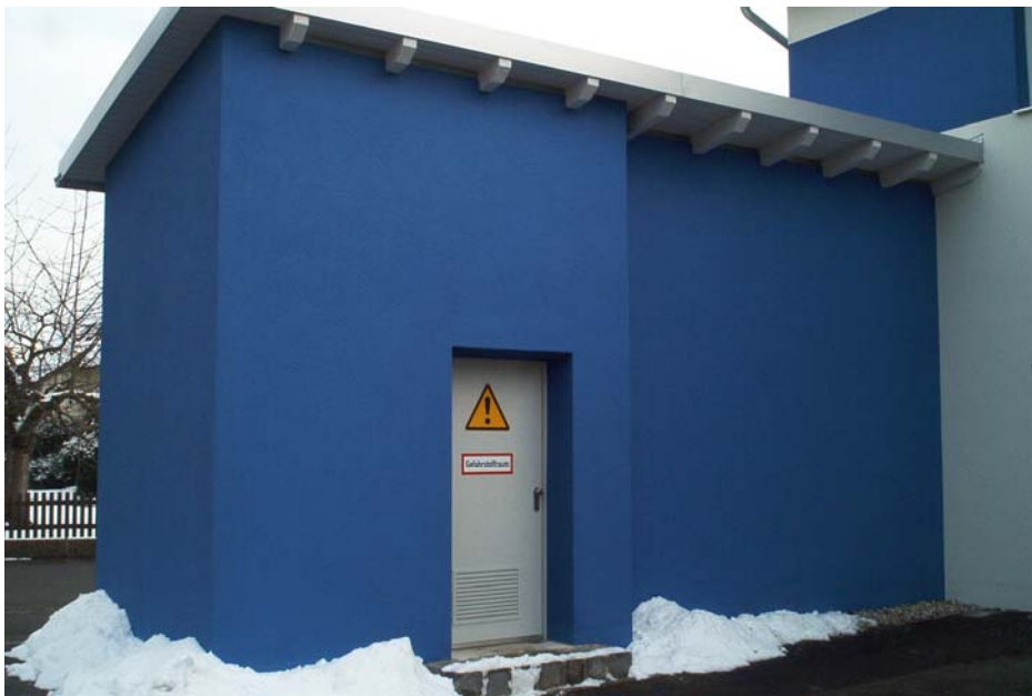
Gefahrstoffraum – Anbau am Verwaltungs- und Werkstattgebäude
